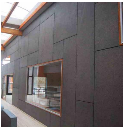
PANELES DE CEMENTO
